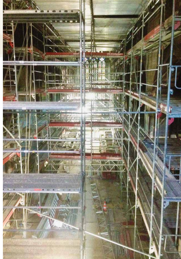
Atmosphère futuriste dans l'église en restauration
