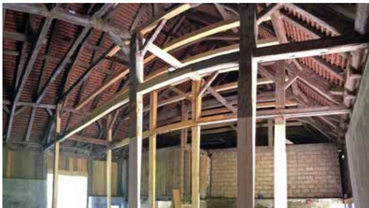
Blick in den Dachstuhl des Hofes La Souche
