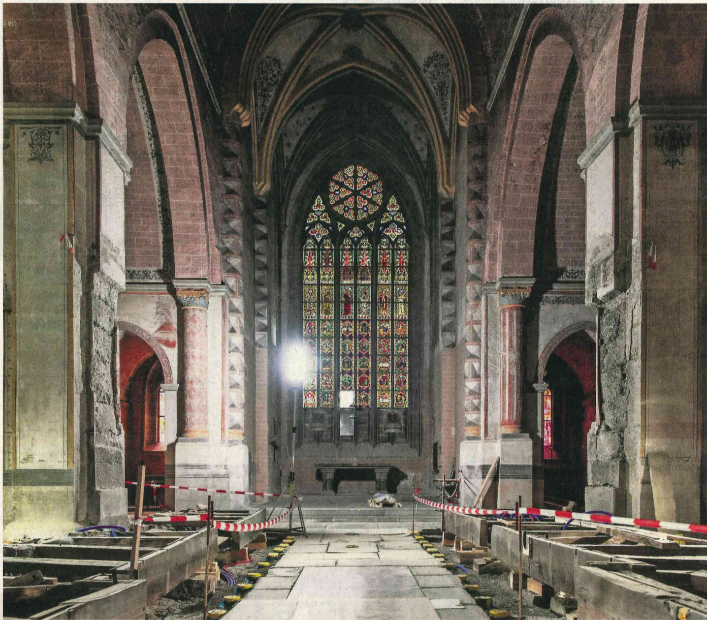
L'église d'Hauterive fait l'objet d'une rénovation complète. Antoine Vullioud
