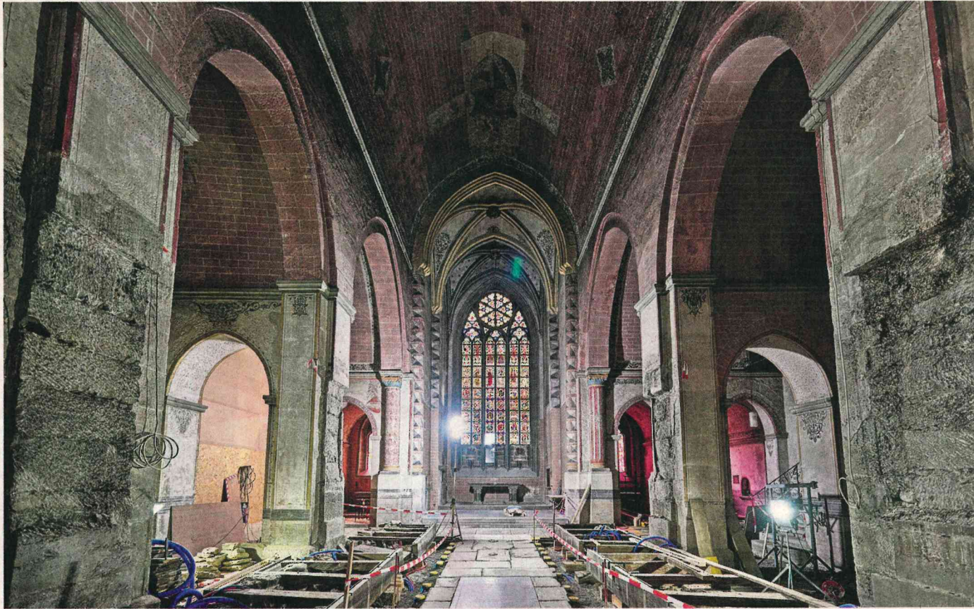
Seit 2021 wird die Kirche der Abtei Altenryf restauriert. 2025 sollen die Arbeiten abgeschlossen werden.
