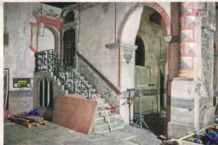
Die Sanierungsarbeiten sind in vollem Gange.
