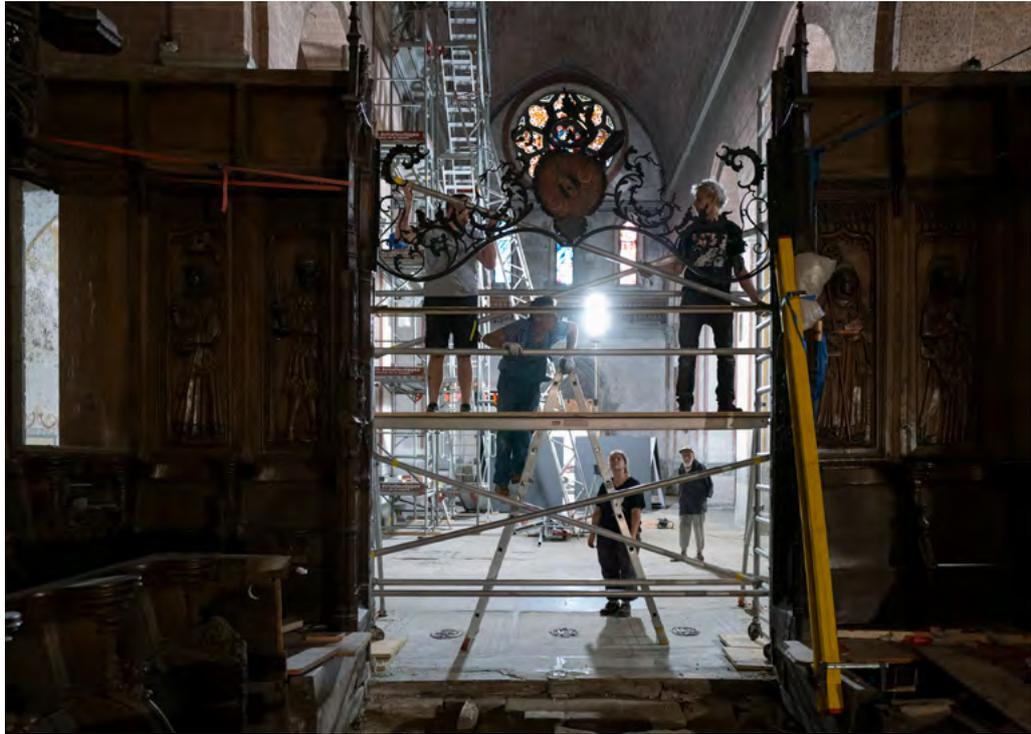
Fig. 14 : Travaux de dépose de la grille en fer forgé.
