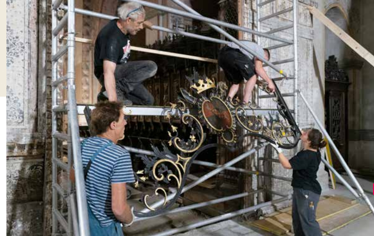
Rimozione del cancello in ferro battuto © Nicolas Brodard
