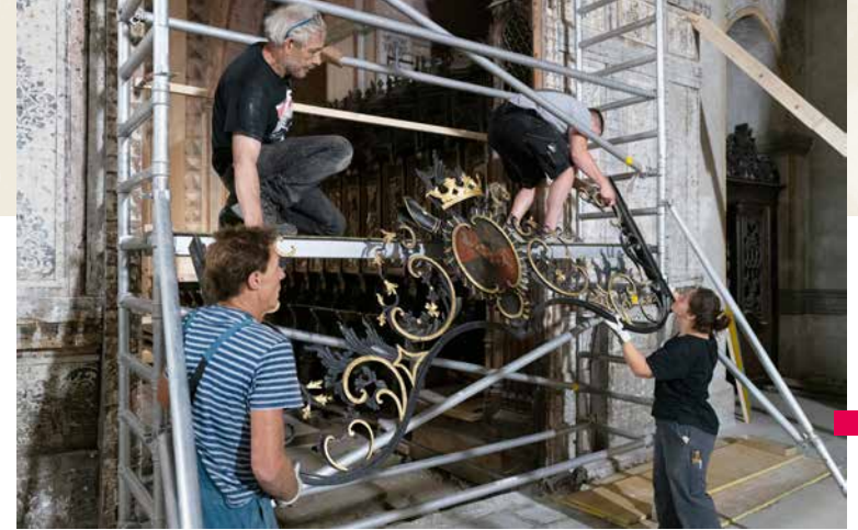
Entfernung des schmiedeeisernen Gitters © Nicolas Brodard
